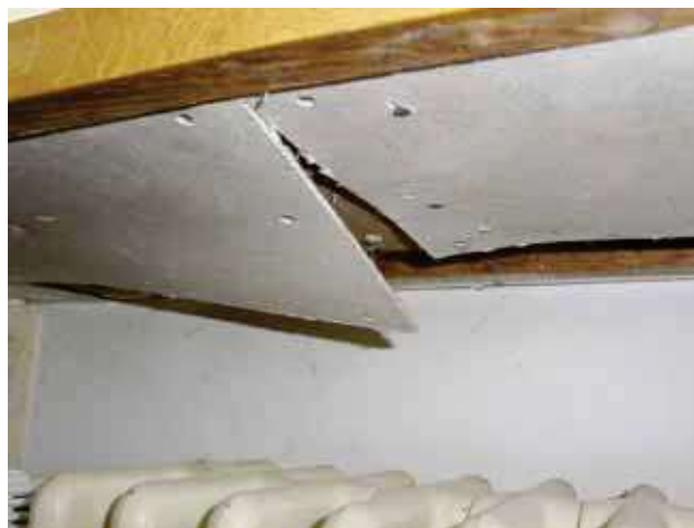
3 Panneaux légers contenant de l'amiante utilisés comme revêtement de protection incendie, par ex. pour les radiateurs.
