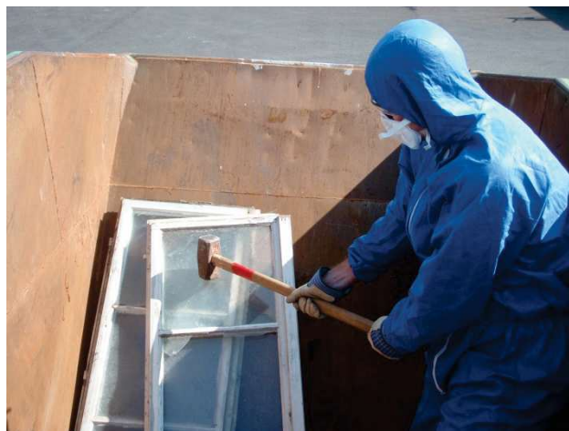
1 Séparation du vitrage au marteau.
