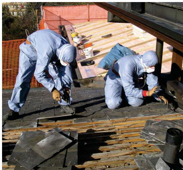
3 Pour éviter de mettre leur santé en danger, les travailleurs doivent effectuer le démontage sans destruction et porter un équipement de protection adapté.
