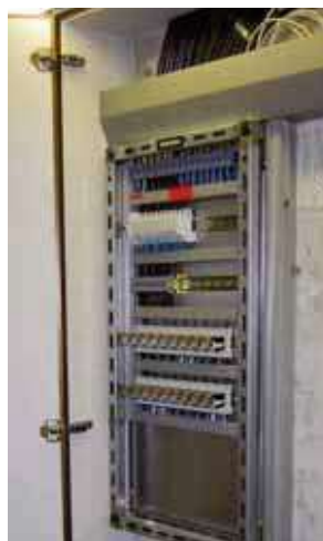
1 Panneaux légers contenant de l'amiante utilisés par ex. comme revêtement de protection incendie pour une armoire électrique (ici, garniture de porte).
