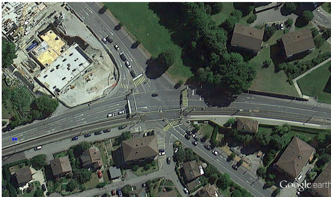
Carrefour route du Chasseur et route de Neuchâtel
