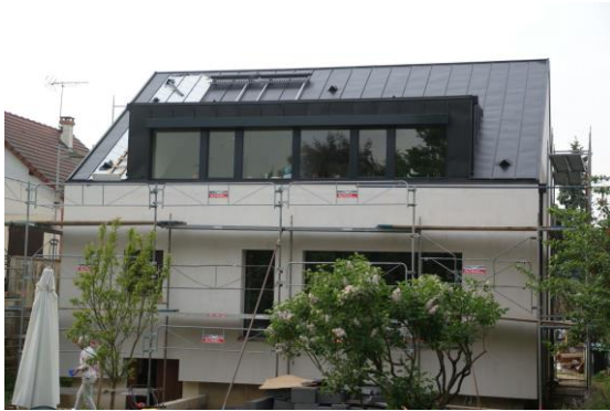
Exemple de lucarne vue de l'extérieur
