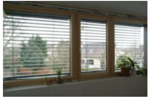
Exemple de lucarne vue de l'intérieur
