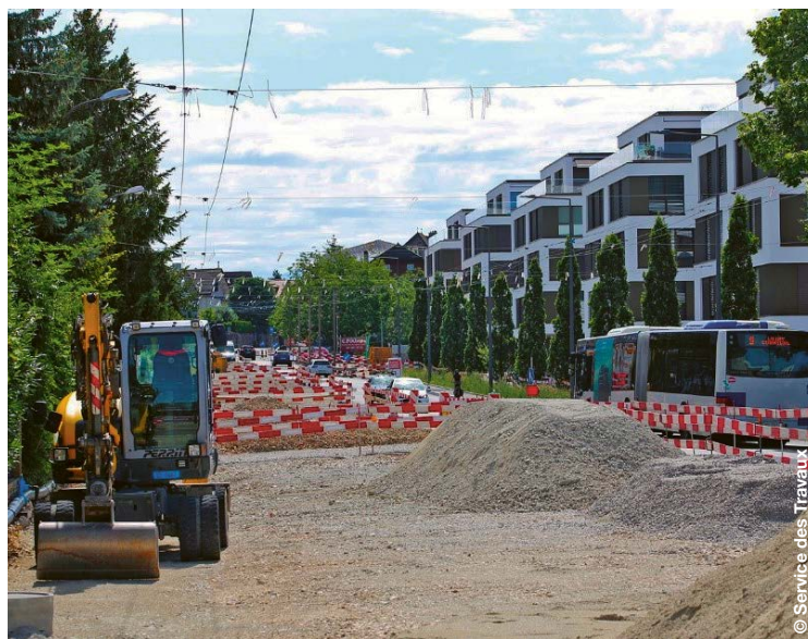
Travaux sur la conduite de gaz
