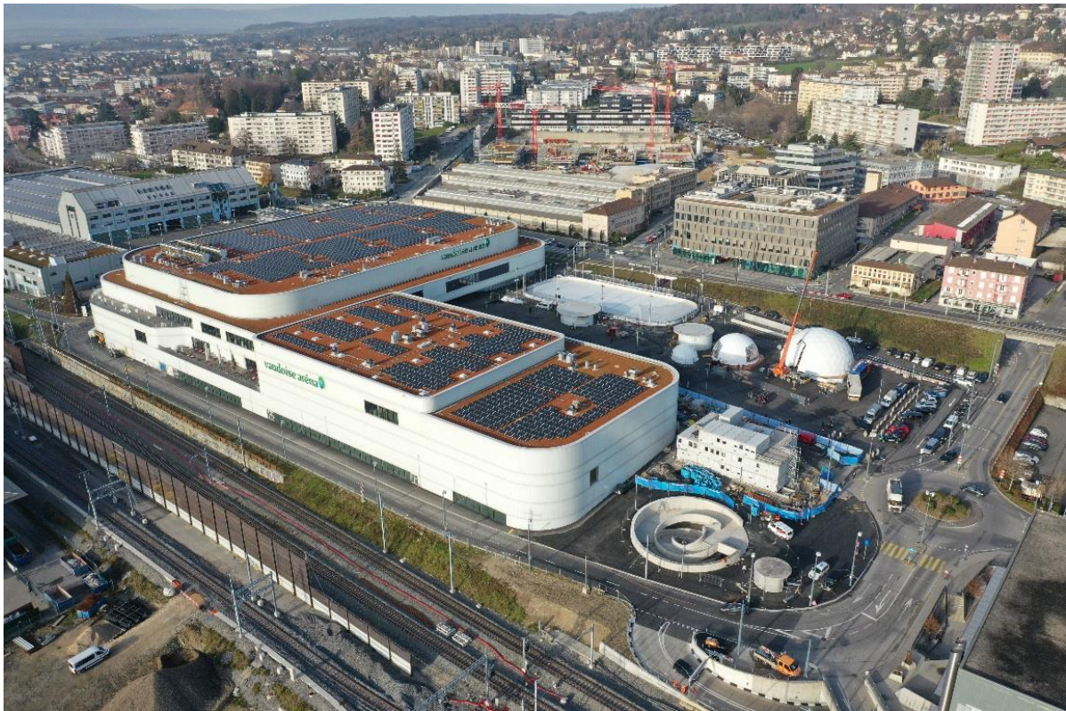
La Vaudoise aréna
