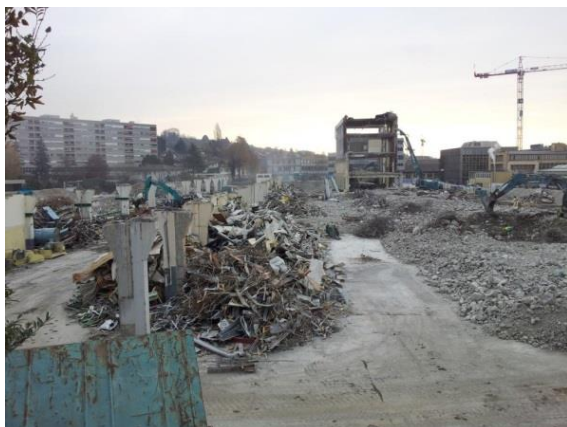
Démolition des anciens bâtiments de l'entreprise Bobst
