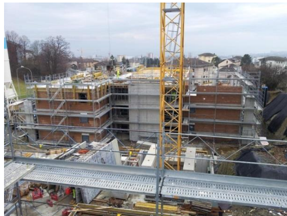
Construction de deux immeubles d'habitation à la rte du Mont
