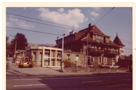
Castelmont en construction
