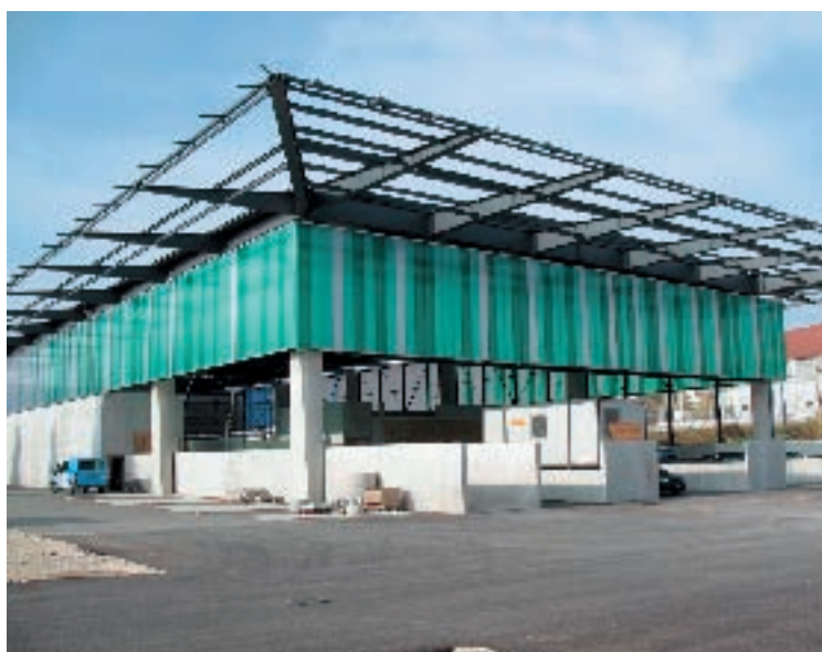
Construction en cours de réalisation.
